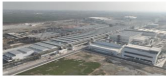
2025年2月25日より生産開始したカルコダ工場
