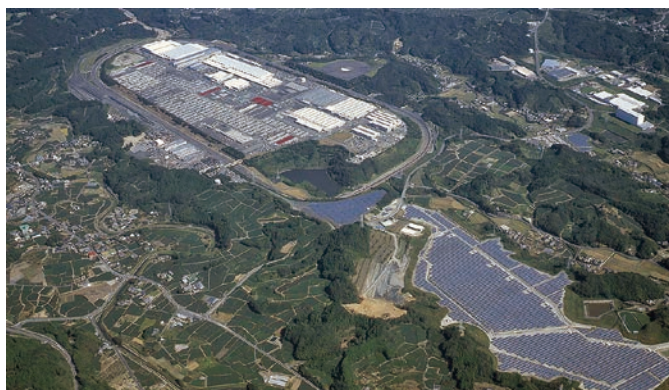
スズキ牧之原太陽光発電所
